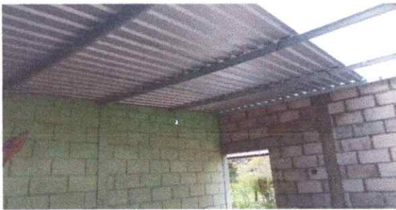
Foto 3: Proceso de sustitución de lámina de cocina en mal estado por lámina troquelada calibre 26
