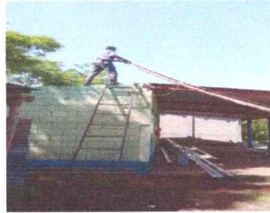
Foto 2: Trabajos de sustitución de estructura metálica en aula en mal estado por estructura portante galvanizada.
