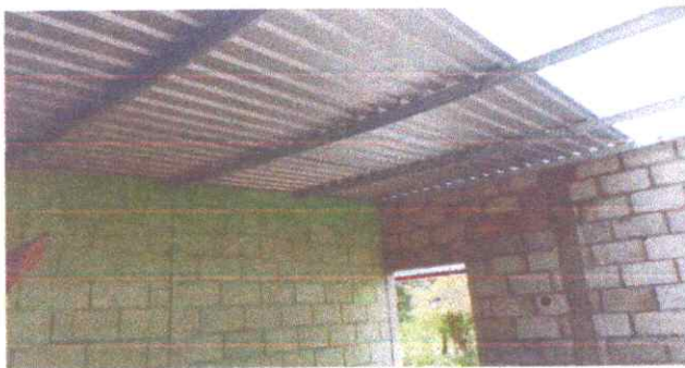
Foto 3: Proceso de sustitucion de lamina en cocina en mal estado por lamina troquelada calibre 26
