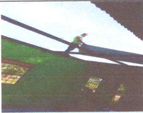
Foto1: Sustitucion de lamina en aula en mal estado en proceso
