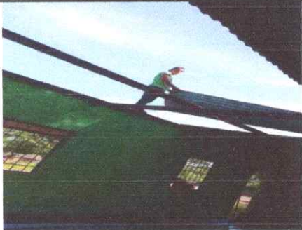
Foto 1: Sustitución de lámina en aula en mal estado, en proceso.
