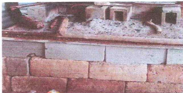
Foto 5: Polletón improvisado a mejorar con block y cemento.
