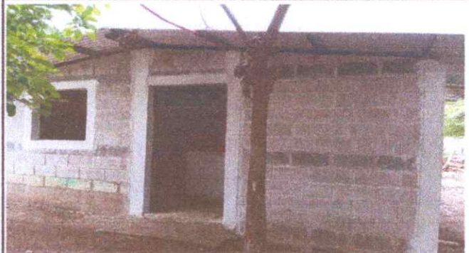
Foto 4: Un costado de la cocina terminado
