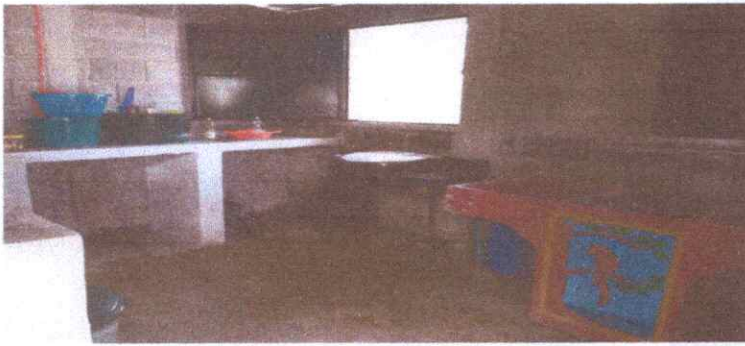
Foto 3: Instalacion de pila para cocina terminado
