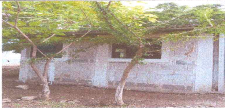
Foto1: Construcción de la frontal de la cocina terminada
