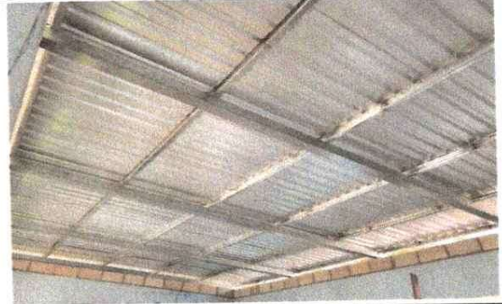
Foto 2: techo segundo grado
