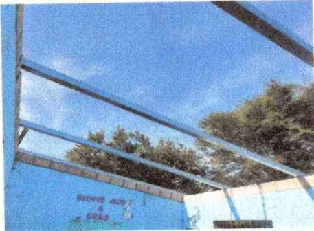
Foto 3: techo del aula de tercer grado
