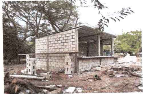
Foto 6: ampliacion y techo de cocina
