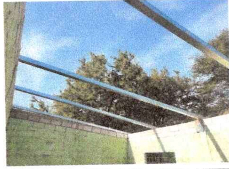
Foto 2: techo segundo grado
