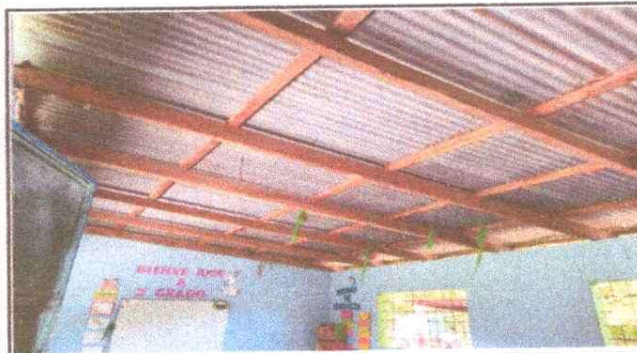
Foto 3: Sustitución de techo del aula de tercer grado
