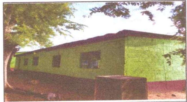
Foto 4: Sustitución de techo de aulas de segundo, tercero y dirección
