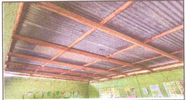
Foto 2: Sustitución de Techo segundo grado
