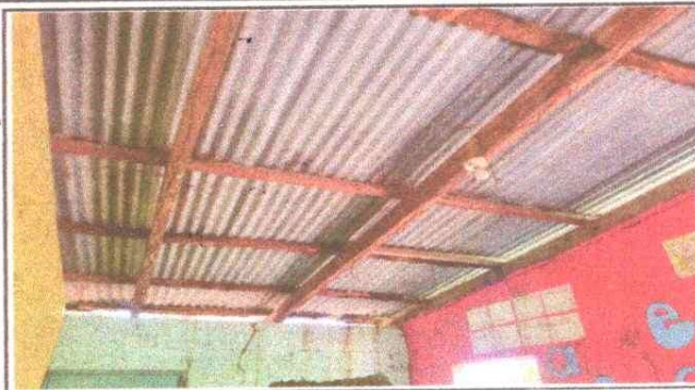
Foto1: Sustitución de Techo de dirección
