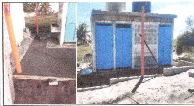
MODULO 5 SUSTITUCION Y MEJORAMIENTO DE SANITARIOS
