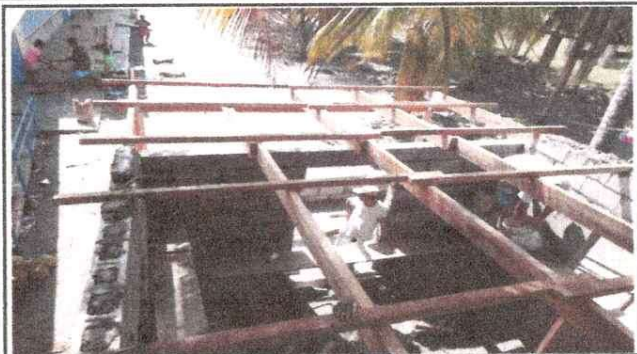
MODULO 2. SUSTITUCION DE TECHO
