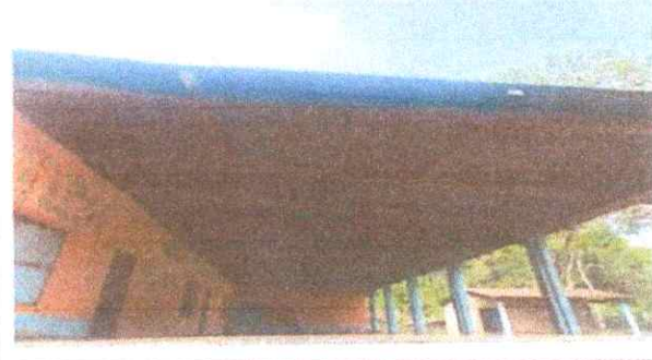
Foto 4: Sustrucción de estructura metálica y lámina de la cocina
