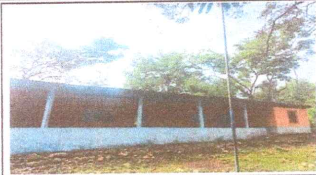
Foto 1: Sustrucción de lamina por lámina troquelada calibre 26
