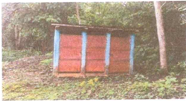
Foto 3: Sustrucción de sanitario, sustustrucción de puertas y techo
