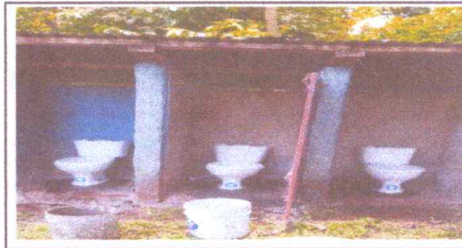
Foto 6: SUSTITUCION DE BAÑOS
