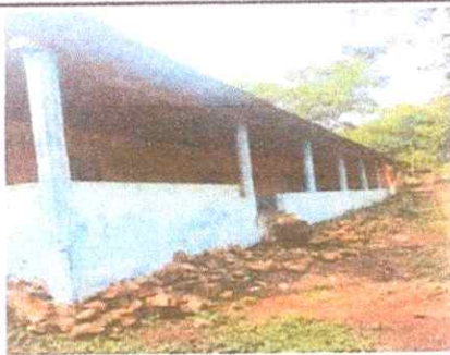
Foto 5: Mejoramiento de banqueta de concreto
