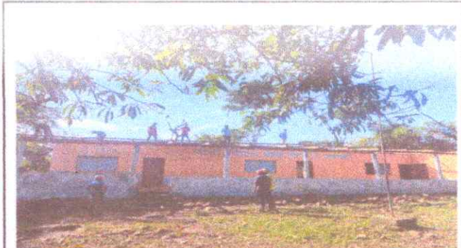
Foto 2: INICIO DE TRABAJOS DE TECHO
