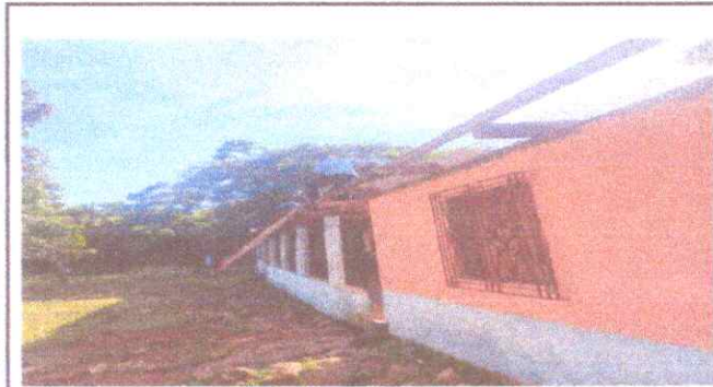
Foto 3: INICIO DE TRABAJOS DE TECHO
