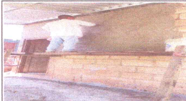
Foto 4: MEJORAMIENTO DE COCINA, REPELLO Y TORTA DE CONCRETO.
