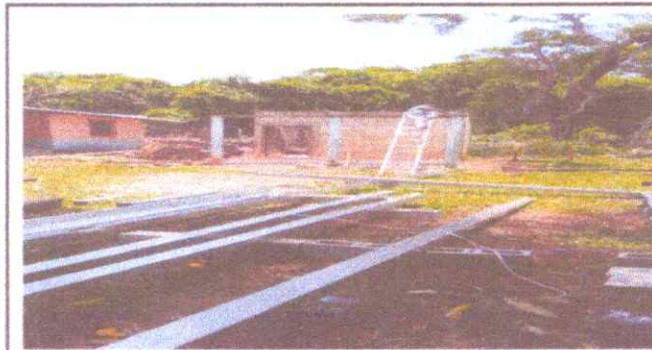
Foto 5: MEJORAMIENTO DE TECHO COCINA
