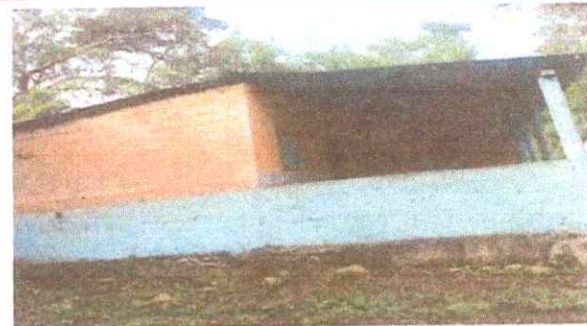
Foto 6: mantenimiento de pintura
