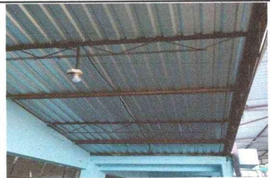
Foto 6: Modulo aulas: la sustitucion de lamina troquelada calibre 26 se ha finalizado en un 100%.
