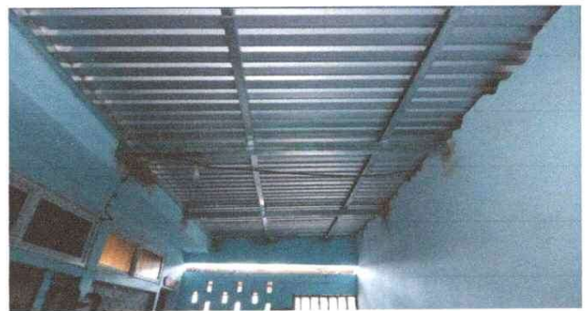
Foto 4: Modulo aulas: cambio de techo finalizado en su totalidad.
