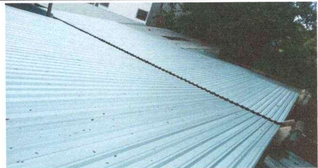
Foto 5: Modulo aulas: techo de duralita que cubre baños, tienda, direccion y salon de clases totalmente nuevo con estructura portante galvanizada y lamina troquelada calibre 26.
