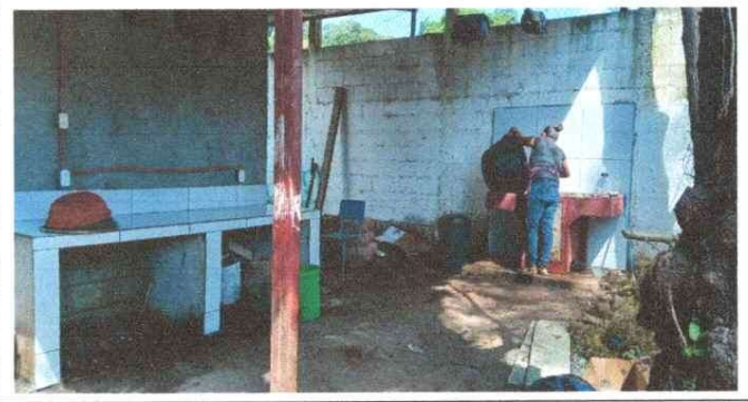
Foto 2: Modulo cocina: Mueble de cocina con instalacion de piso para evitar humedad y en area de pila para evitar salpicaderas, totalmente finalizado.
