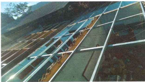
Foto 5: Modulo aulas: techo de duralita que cubre baños, tienda, direccion y salon de clases completamente con estructura listo para poder techar con lamina nueva.
