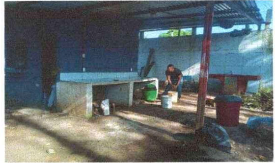
Foto 2: Modulo cocina: Mesa de cemento mejorada con piso cerámico en superficie (area anexa).
