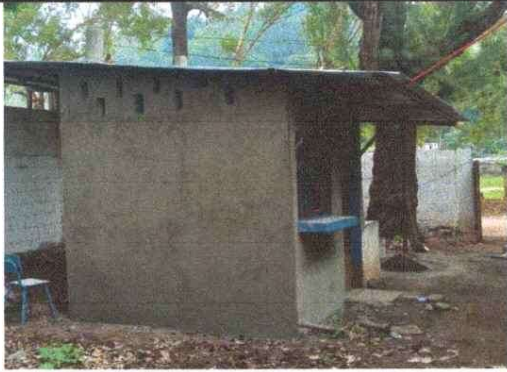
Foto 1: Modulo cocina: Paredes exteriores repelladas en su totalidad.
