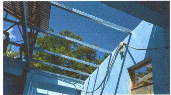
Foto 4: Modulo aulas: sustitucion de lamina de fibro cemento por estructura portante en un 75% de avance.
