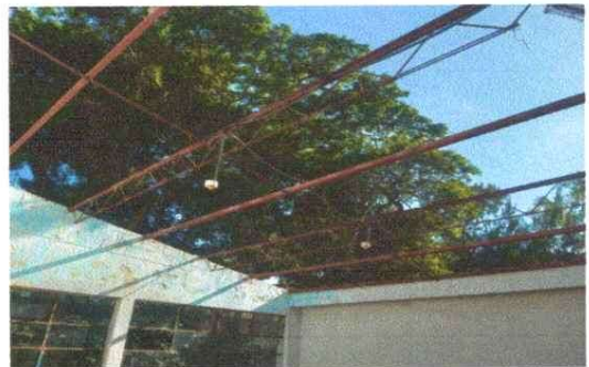
Foto 6: Modulo aulas: espacio listo para poder sustituir lamina canalada por lamina troquelada.
