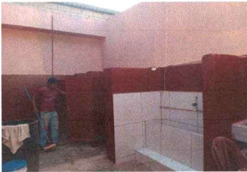
Foto 3: Modulo baños: paredes de baños en un avance de 80% a falta de aplicar la segunda mano de pintura.
