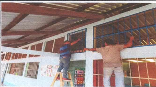
Foto 3: Colocando balcones
