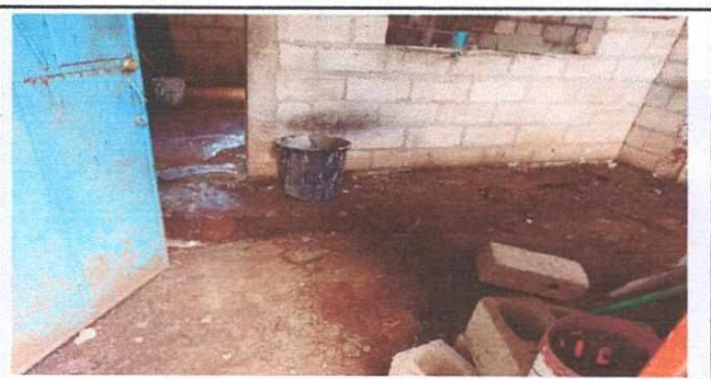
Foto 6: Cambio de piso, repello y cernido
