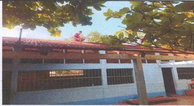
Foto1: inicio de cambio de techo
