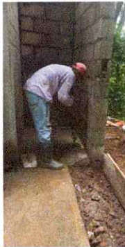
Foto 3: Instalación de sanitarios de cerámica lavables nuevos en desarrollo.
