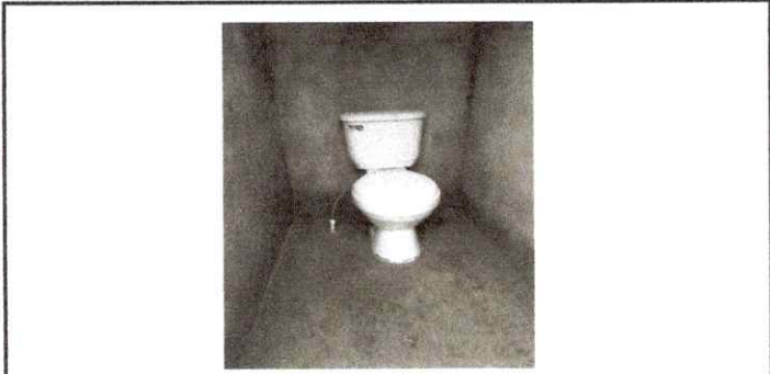
Foto13: Sustitución de nuevo sanitario lavable de ceramica, concluido.
