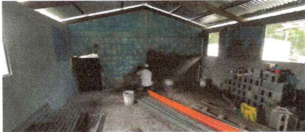
Foto 7: Mejoramiento de paredes de aula en proceso.
