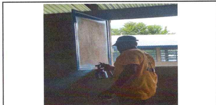
Foto 15: Proceso de mejoramiento de ventanas de aula con pintura, lijado y soldadura.
