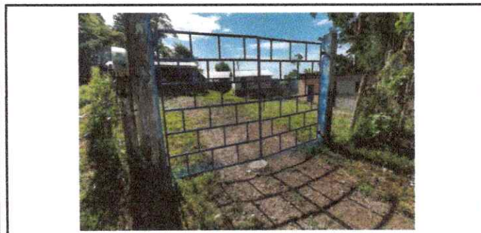
Foto 17: Detalles finales de mejoramiento de portón principal.
