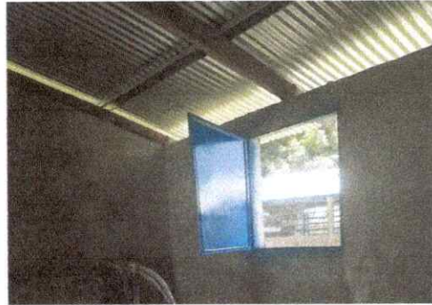
Foto 8: Detalles finales de mantenimiento de ventanas metálica de Aula (lijado, pintura y soldadura)
