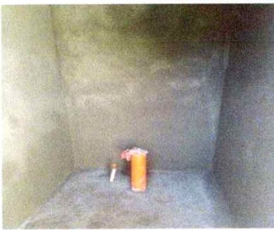
Foto 11: Reparación de paredes de sanitario y de tubería de montaje/conexión de sanitario lavable de cerámica, finalizado.
