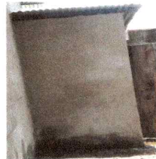
Foto 12: Sustitución de lámina en mal estado en sanitarios por laminada troquelada calibre 26 culminado.
