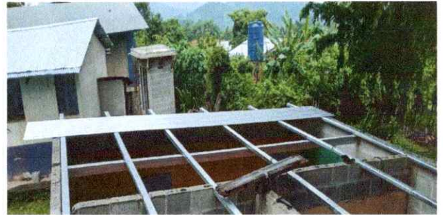
Foto 4: Trabajos finales de sustitución de estructura dañada por estructura portante galvanizada en cocina.
