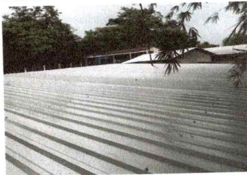
Foto 2: Sustitución de lámina dañada por lámina troquelada calibre 26 en cocina, finalizada.
