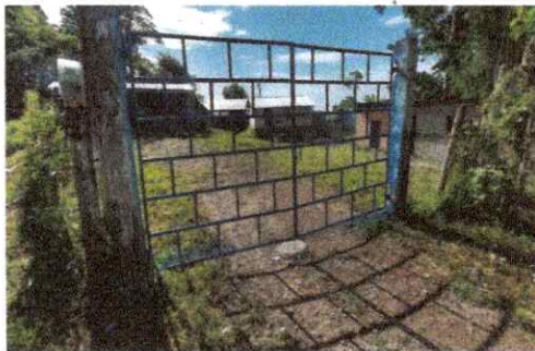
Foto 17: Detalles finales de mejoramiento de portón principal.
