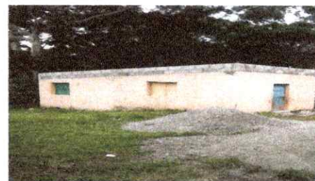
Foto 18: levantado de cuatro paredes dos iladas de block del aula en proceso
