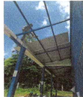
Foto 10: Desarrollo de trabajos de mantenimiento de estructura metálica portante en aulas (lijado y pintura)
