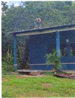
Foto 9: Proceso de sustitución de lámina en mal estado por lamina troquelada calibre 26 en aulas.
