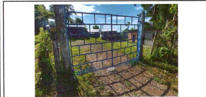
Foto 17: Detalles finales de mejoramiento de portón principal.
