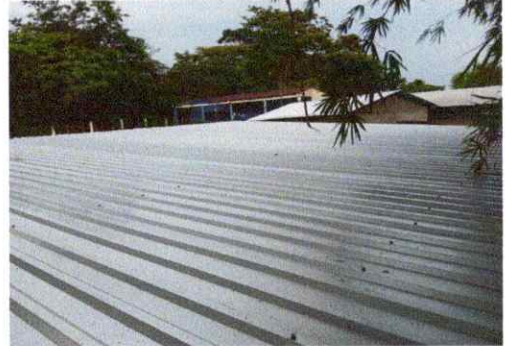
Foto 2: Sustitución de lámina dañada por lámina troquelada calibre 26 en cocina, finalizada.
