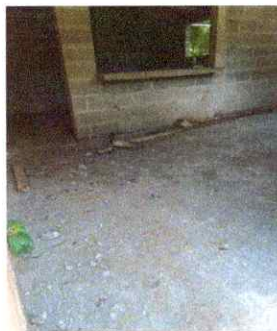
Foto 5: Mejoramiento de torta de cemento en cocina finalizados.
