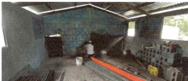
Foto 7: Mejoramiento de paredes de aula en proceso.
