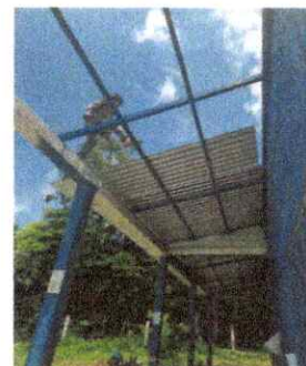
Foto 10: Desarrollo de trabajos de mantenimiento de estructura metálica portante en aulas (lijado y pintura)
