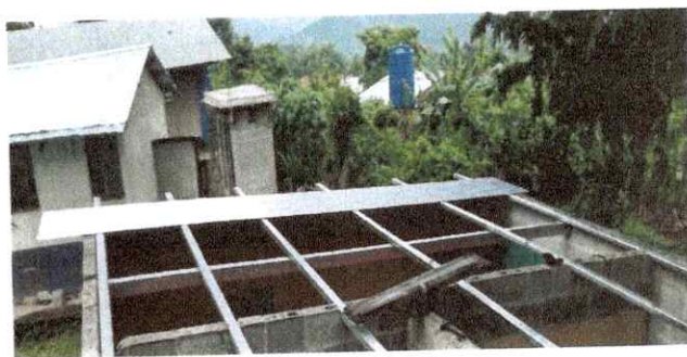
Foto 4: Trabajos finales de sustitución de estructura dañada por estructura portante galvanizada en cocina.
