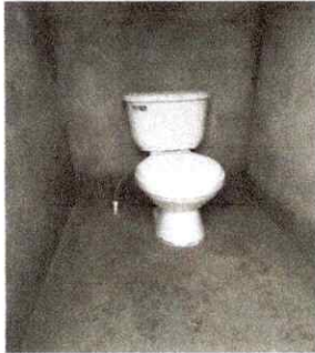
Foto13: Sustitución de nuevo sanitario lavable de ceramica, concluido.
