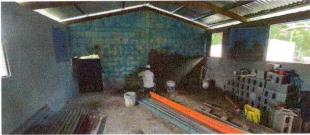
Foto 7: Mejoramiento de paredes de aula en proceso.
