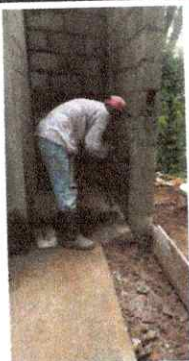
Foto 3: Instalación de sanitarios de cerámica lavables nuevos en desarrollo.
