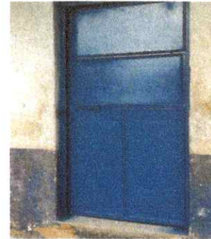
Foto 16: Mejoramiento de puertas de aula lijado y pintura en ejecución.
