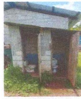
Foto 6: TECHO Y AREA DE SANITARIOS EN MAL ESTADO ( INSTALACIÓN DE TINACO SOBRE TERRAZA DE CEMENTO QUE SUSTITUIRÁ EL TECHO PROVISIONAL)
