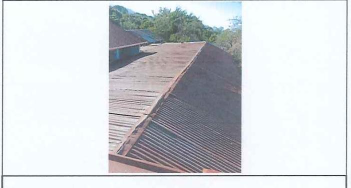
Foto 4: Techo que abarca 3 aulas en mal estado
