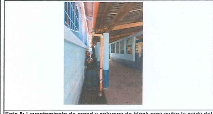
Foto 5: Levantamiento de pared y columna de block para evitar la caída del agua a una de las aulas ya que esto afecta a los alumnos y así mismo deterioro de pared
