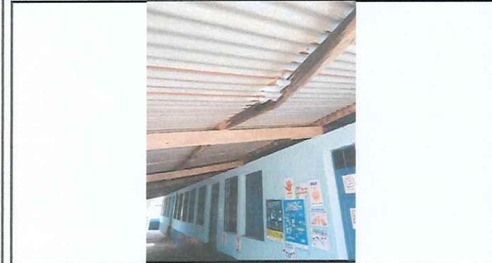
Foto1: Corredor que abarca tres aulas con vigas de madera y láminas en mal estado
