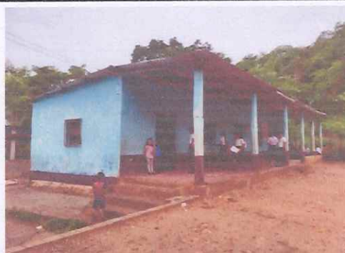
Foto4: cambio de pilares a pilares de metal
