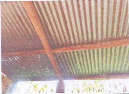
foto7: Sustitucion de estructura de madera por estructura metalica
