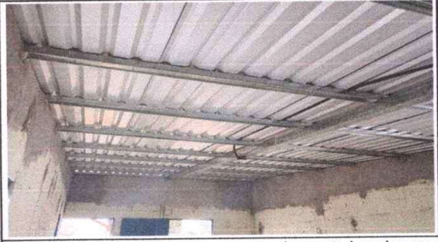
Foto 2: Modulo Aula, sustitucion de estructura de soporte de madera por metal
