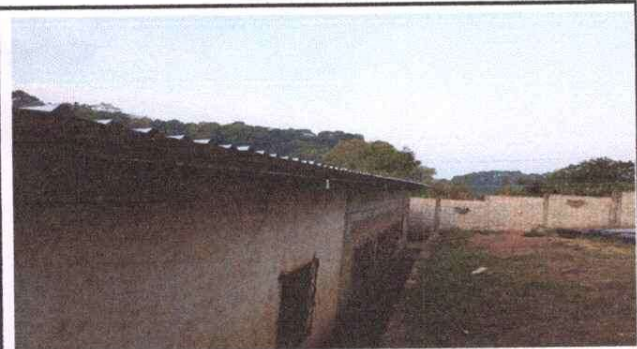
Foto 3: Modulo aula: Nivelación de pared
