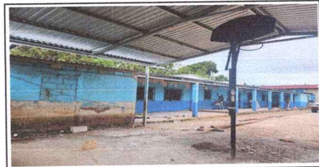
Foto 6: Modulo Aula: Sustitucion de costanera de madera a metal galvanizada
