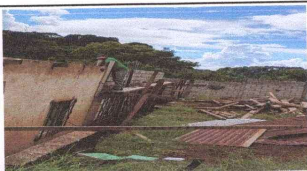
Foto 3: Modulo aula: Nivelación de pared
