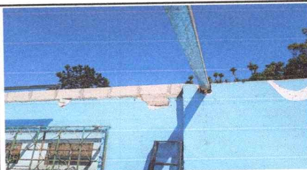
Foto 4: Modulo Aula: Nivelacion de pared
