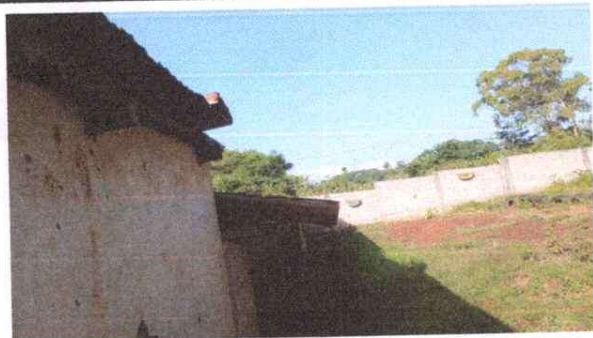
Foto 3: Modulo aula: Nivelación de pared
