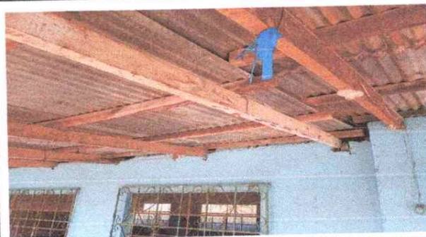
Foto 4: Modulo Aula: Nivelacion de pared
