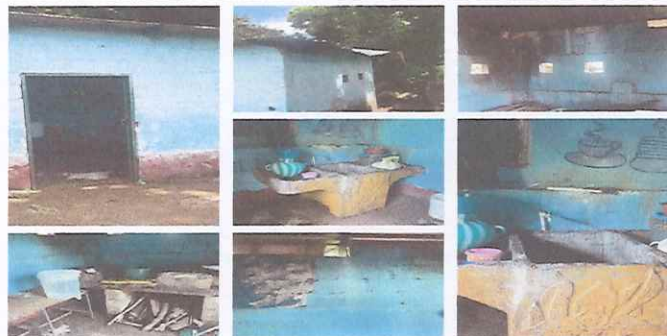
Foto1: Cocina sin piso y sin repello, se cubrira con terraza para mayor seguridad y se instalara un tinaco para garantizar el servicio de agua.
