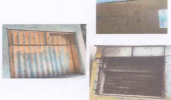
Foto 4: Ventana en mal estado se sustituiran para mayor seguridad de la escuela,
