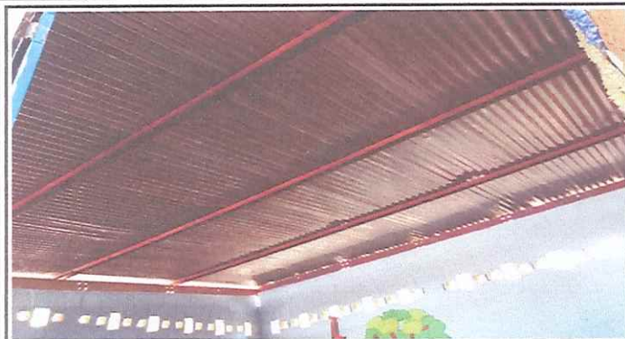
Foto1: Sustitucion de estructura de soporte de metal en mal estado por estructura de aluminio.
