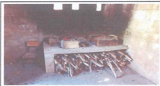
Foto 6: Mejoramiento de polleton e instalacion de plancha y chimenea en cocina.
