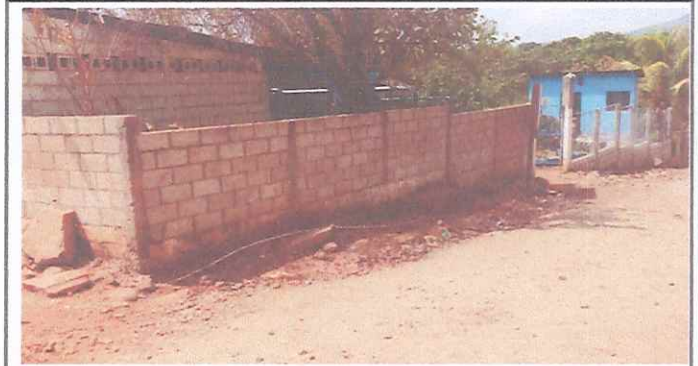
Foto 10: Repello de muro perimetral.
