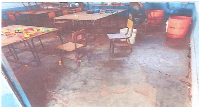
Foto 3: Sustitucion de torta lisa en mal estado por piso de granito en modulo 1, y 3
