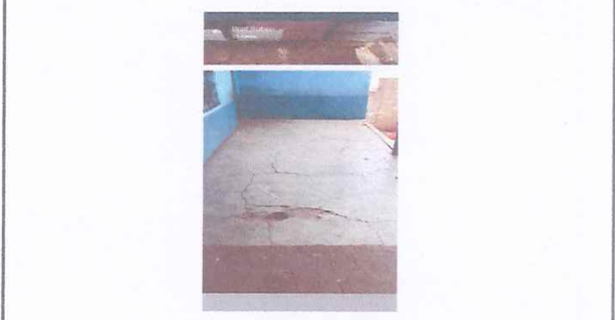
FOTO14: sustitucion de torta lisa en mal estado por piso de granito en area de corredor modulo 3.
