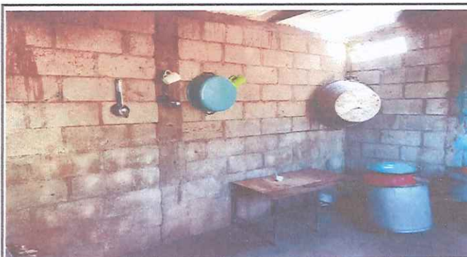
Foto 4: Repello de paredes interiores de cocina
