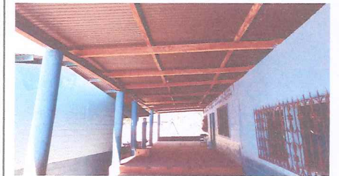
Foto13: Sustitucion de estructura de soporte por estructura de aluminio y lamina de metal por lamina troquelada de aluzin (en mal estado) en area de corredor modulo 1, 2 y 3.
