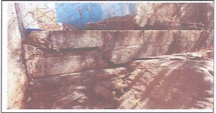
Foto 12: reparación de muro perimetral con base, postes de cemento y malla .
