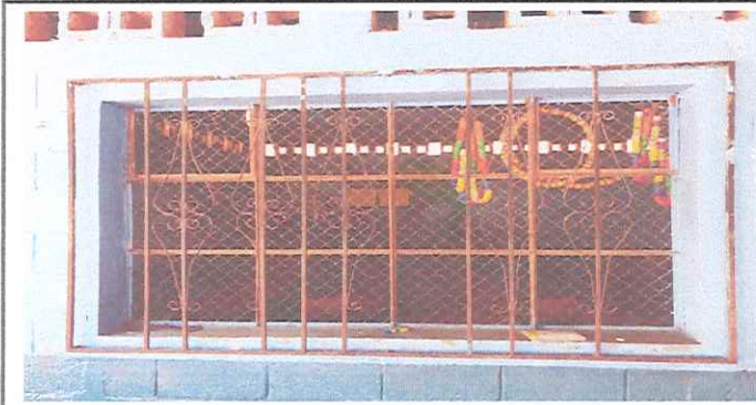
Foto 9: Reparación de balcones modulo 1 y 2.
