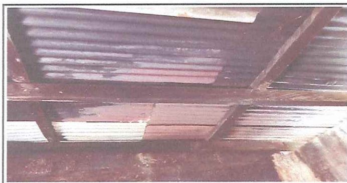
Foto 5: Sustitucion de lamina en mal estado por lamina troquelada de aluzin C, y sustitucion de estructura de soporte de madera en mal estado, en la cocina
