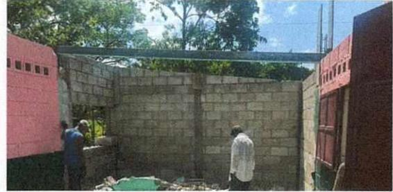
Foto 2: Etapa de desmontado de lámina que se encontraba en mal estado para luego colocar la lámina troquelada calibre 26 legitima
