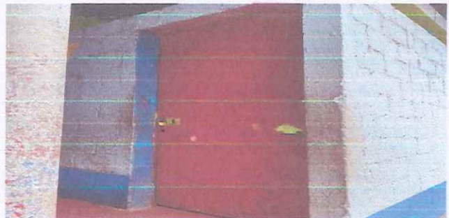
Foto 6: Sustitución de puerta de madera comprimida por puerta de metal con chapa
