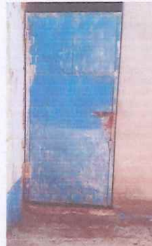
Foto 4: Reparación de puertas metálicas dañadas, Renovación con lijado y pintura
