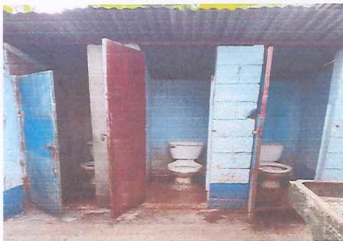
Foto 3: Sustitución y ampliación de techo modulo de sanitarios con lámina troquelada calibre 26 y estructura galvanizada
