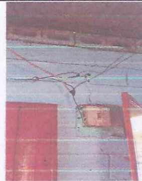
Foto 4: Sustitución de flipón
