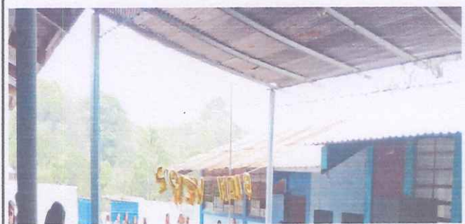
Foto 6: Reparación y ampliación de estructura metálica de una galera inter-aulas
