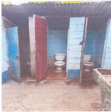
Foto1: Sustitución de torta de cemento por piso cerámico antideslizante
