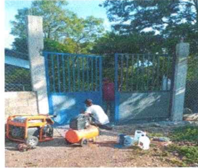
Foto 2: Culminación de trabajos para la instalación de Portón Metálico en el area de acceso principal del establecimiento.
