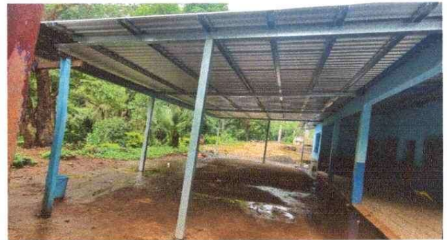
Foto 4: Tabajos de sustitución de lámina en mal estado por lámina troquelada calibre 26 en área de patio culminados.
