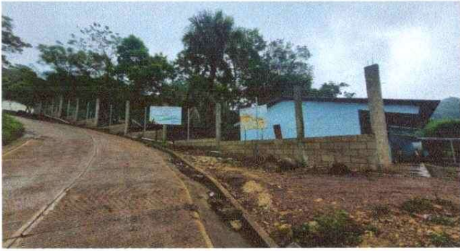
Foto1: Trabajos de mejoramiento de muro perimetral con malla metálica y tubo de metal galvanizado finalizados.
