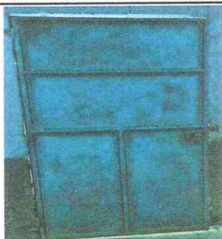
Foto 5: Sustitución de chapa de puerta metálica de aula No. 4
