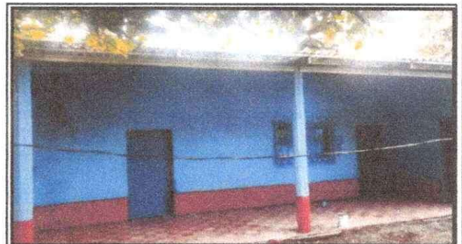
Foto 4: Módulo Aulas, mejoramiento de ventanas, puertas, pintura y muros.
