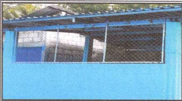
Foto 1: Módulo Cocina, sustitución de techo.
