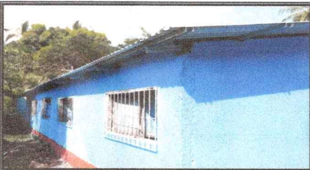
Foto 3: Módulo Aulas, sustitución de techo.
