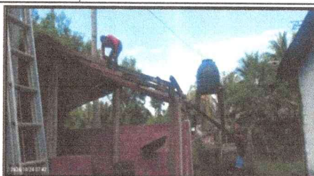
Foto 2: Módulo Cocina, mejoramiento de paredes, piso y pintura.
