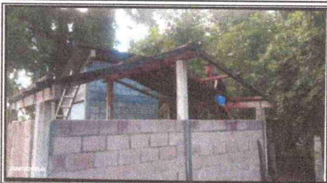
Foto 1: Módulo Cocina, sustitución de techo.
