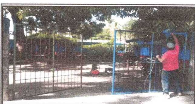
Foto 6: Módulo portón, sustitución de tela metálica y pintura.
