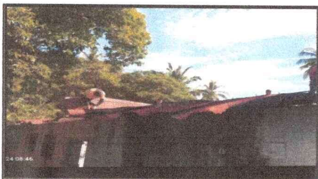
Foto 3: Módulo Aulas, sustitución de techo.
