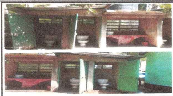
Foto 5: Módulo Baños, reparación de puertas, cambio de accesorios, de tazas y cambio de tubería para tinaco.
