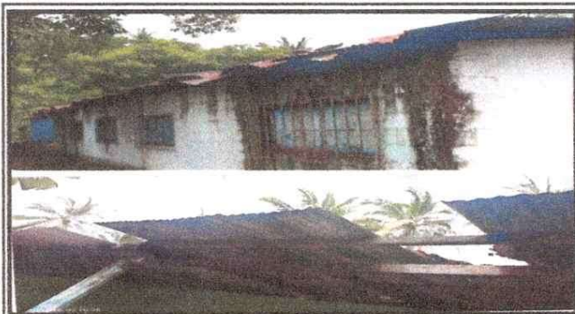
Foto 3: Módulo Aulas, sustitución de techo.
