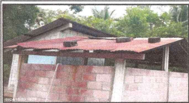
Foto 1: Módulo Cocina, sustitución de techo.
