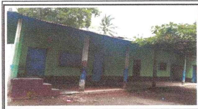
Foto 4: Módulo Aulas, mejoramiento de ventanas, puertas, pintura y muros.
