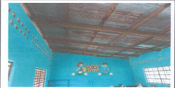
Foto 3: SUSTITUCIÓN DE ESTRUCTURA DE MADERA, POR METAL
