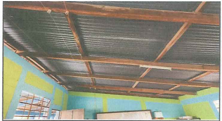
MODULO 1. SUSTITUCION DE SISTEMA ELECTRICO
