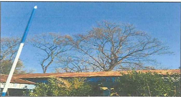
MODULO 1. CAMBIO DE TECHADO
