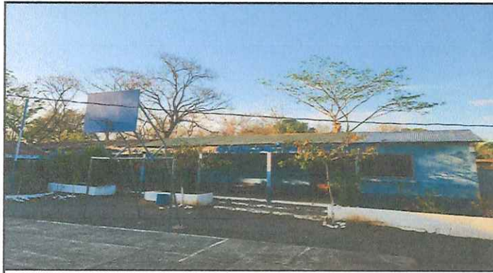
MODULO 1. SUSTITUCION DE TECHO
