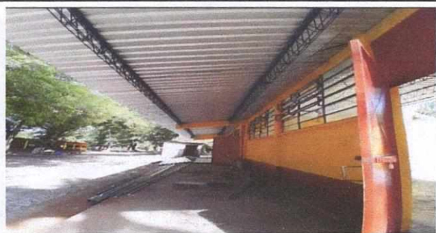
Foto 5: SUSTITUCION DE LAMINA
