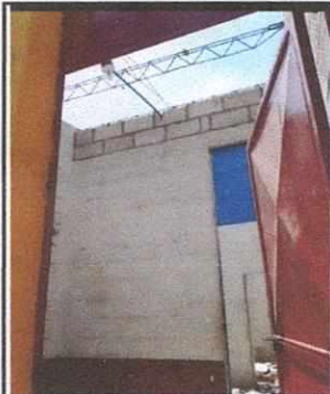
Foto 3: MEJORAMIENTO DE ESTRUCTURA
