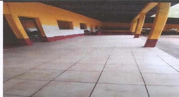
Foto 6: SUSTITUCION DE PISO
