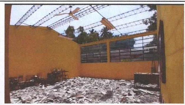
Foto 4: SUSTITUCION DE TECHO
