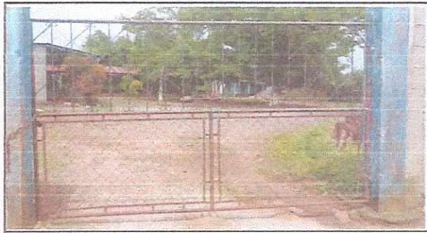
Foto 6: Sustitución de portón de metal
