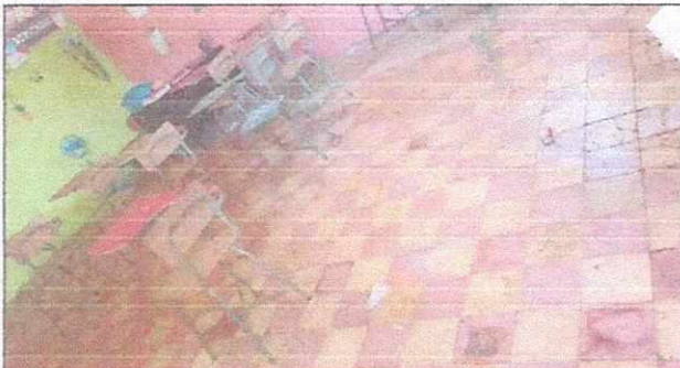
Foto 3: Sustitución del piso de granito por piso ceramico
