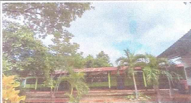
Foto1: Sustitución del techo del corredor y dos salones
