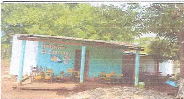
Foto 5: Sustitución de techo y ampliación de galera con muro perimetral y malla
