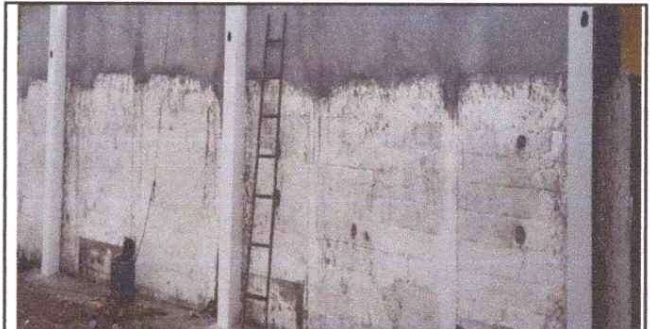
Foto 4: REFORZAMIENTO DE PILARES EN PARED
