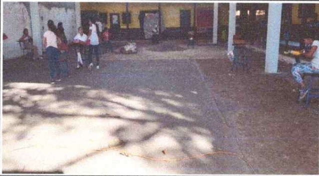
Foto 1: AMPLIACIÓN DE ENTORTADO DE CONCRETO
