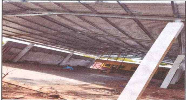
Foto 2: AMPLIACIÓN DE ESTRUCTURA DE TECHO DEL PATIO
