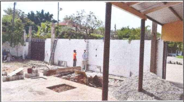
Foto 4: REFORZAMIENTO DE PILARES EN PARED
