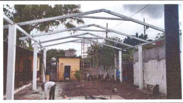
Foto 2: AMPLIACIÓN DE ESTRUCTURA DE TECHO DEL PATIO
