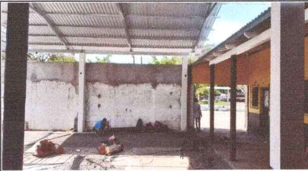
Foto 1: AMPLIACIÓN DE ENTORTADO DE CONCRETO
