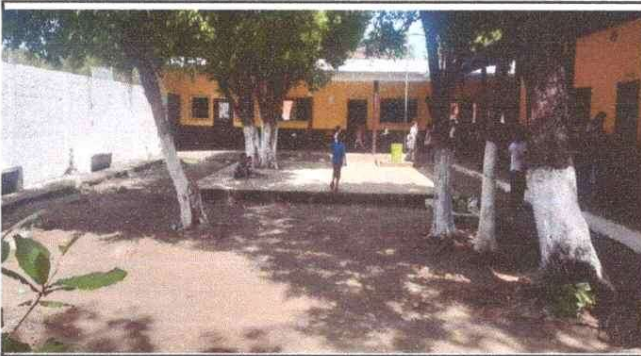
Foto 3: MEJORAMIENTO DE TECHO DEL PATIO CON LÁMINA TROQUELADA CALIBRE 26"
