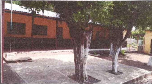
Foto 1: AMPLIACIÓN DE ENTORTADO DE CONCRETO
