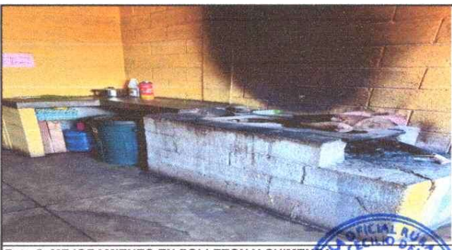
Foto 5: MEJORAMIENTO EN POLLETON Y CHIMENEA
