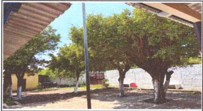
Foto 2: AMPLIACIÓN DE ESTRUCTURA DE TECHO DEL PATIO
