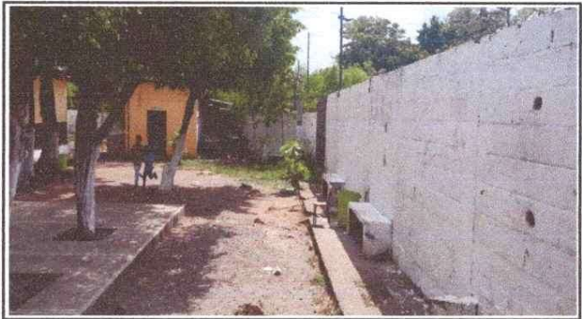
Foto 4: REFORZAMIENTO DE PILARES EN PARED
