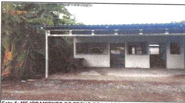
Foto 5: MEJORAMIENTO DE TECHO DE LA COCINA Y SISTEMA ELECTRICO
