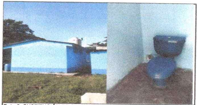
Foto 6: SUSTITUCIÓN DE SANITARIOS Y SUSTITUCION DE TINACO DE 1100 LITROS
