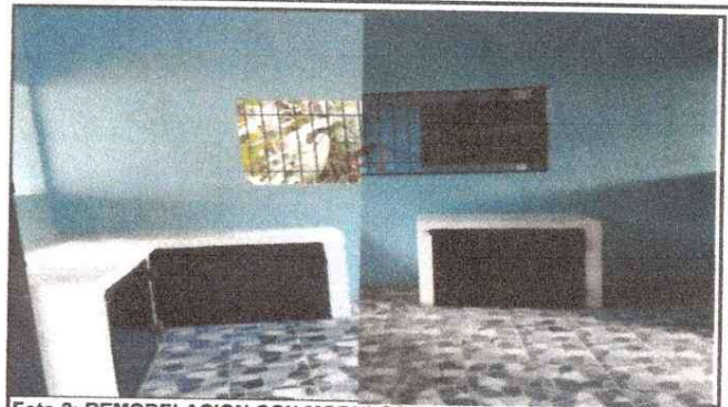
Foto 2: REMODELACION CON MODULOS PARA AGUARDAR ALIMENTOS CON PUERTECITAS DE METAL
