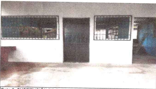
Foto 3: SUSTITUCIÓN DE PUERTAS Y BALCONES EN COCINA
