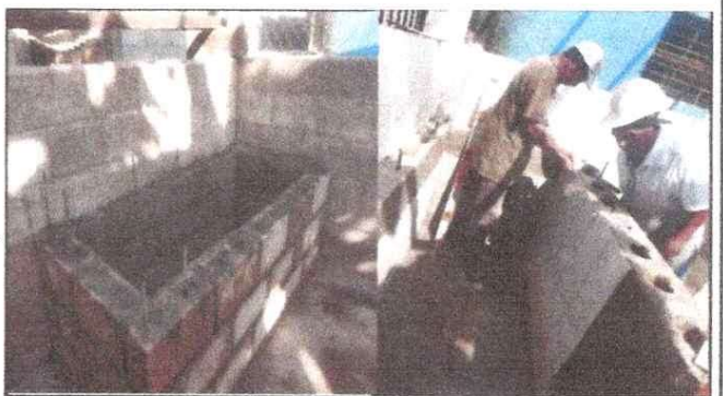
Foto 4: SUSTITUCIÓN Y MEJORAMIENTO DE PILA DE LA COCINA Y REPARACION DE DRENAJE Y AGUA POTABLE
