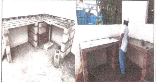
Foto 2: REMODELACION CON MODULOS PARA AGUARDAR ALIMENTOS CON PUERTECITAS DE METAL
