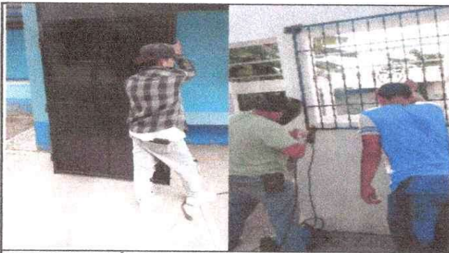
Foto 3: SUSTITUCIÓN DE PUERTAS Y BALCONES
