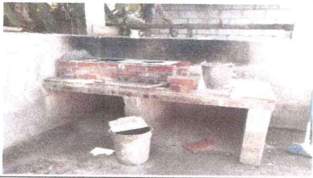
Foto1: MEJORAMIENTO DEL POLLETON Y CHIMENEA
