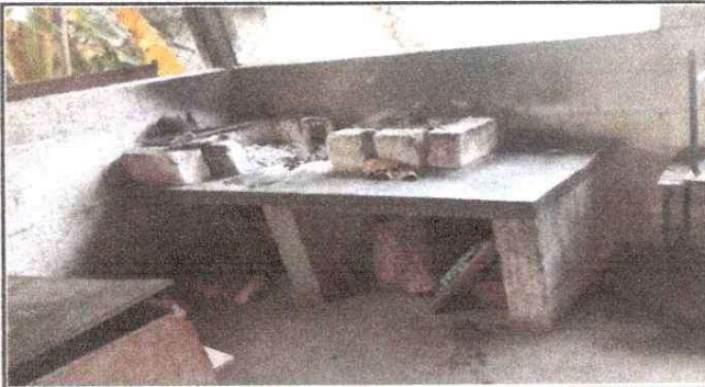
Foto 1: MEJORAMIENTO DEL POLLETON Y CHIMENEA
