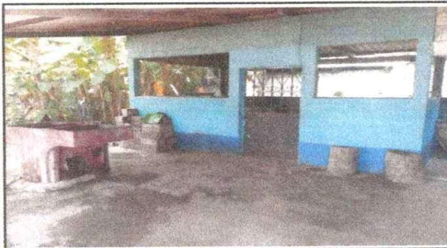
Foto 3: SUSTITUCIÓN DE PUERTAS Y BALCONES EN COCINA
