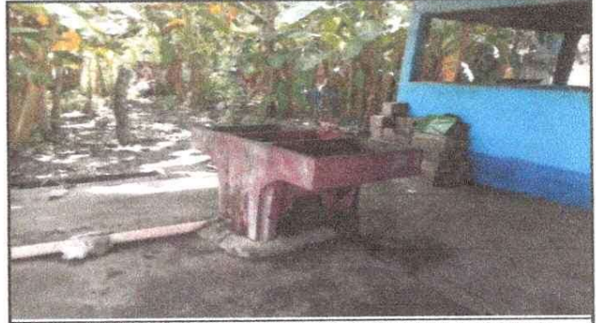
Foto 4: SUSTITUCIÓN Y MEJORAMIENTO DE PILA DE LA COCINA Y REPARACION DE DRENAJE Y AGUA POTABLE
