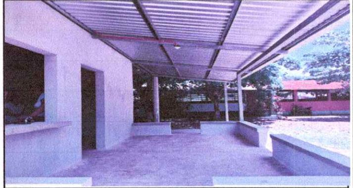
Foto 2: SUSTITUCION DE TECHO Y MEJORAMIENTO DE SISTEMA ELECTRICO DE COCINA
