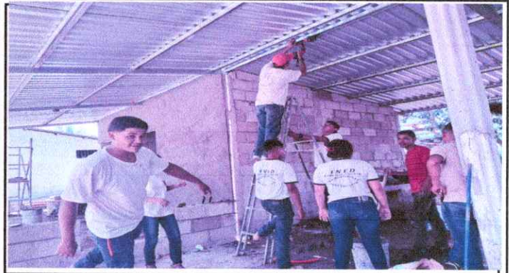
Foto 2: SUSTITUCION DE TECHO Y MEJORAMIENTO DE SISTEMA ELECTRICO DE COCINA
