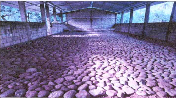
Foto 3: MEJORAMIENTO DE TORTA DE CEMENTO DE SALON DE USO MULTIPLES
