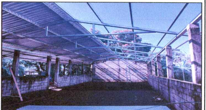
Foto 4: MEJORAMIENTO DE TECHO DE SALON DE USO MULTIPLES
