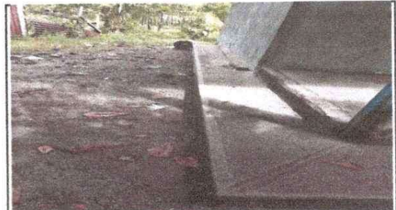
Foto 4: FINALIZACION DE BANQUETA
