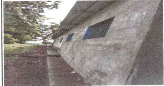
Foto 2: FINALIZACION DE PAREDES DE AULA
