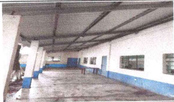
Foto 3: FINALIZACION DE ESTRUCTURA METALICA DEL TECHO
