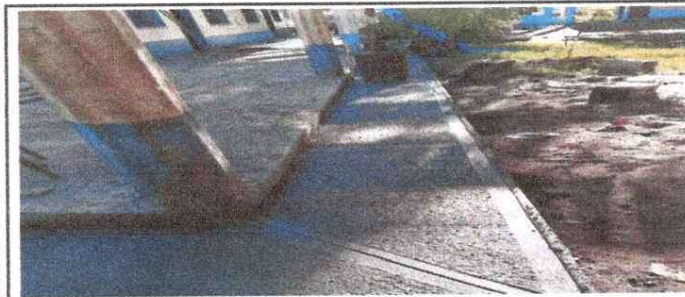
Foto 3: FINALIZACIÓN DE BANQUETA
