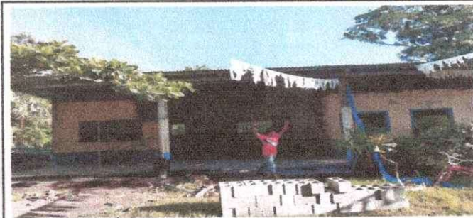
Foto 1: FINALIZACION DE PAREDES DE AULA
