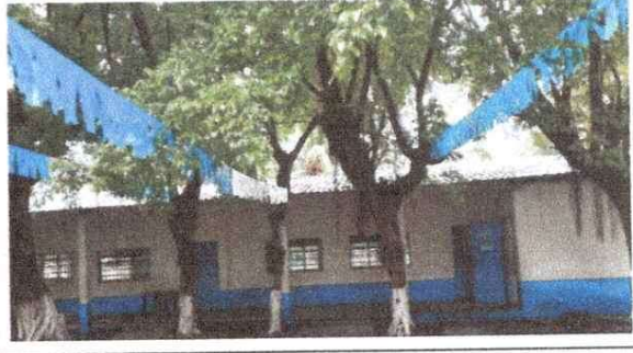
Foto 2: FINALIZACION DE ESTRUCTURA Y TECHO
