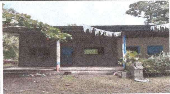
Foto 1: FINALIZACIÓN DE ESTRUCTURA, TECHO PAREDES
