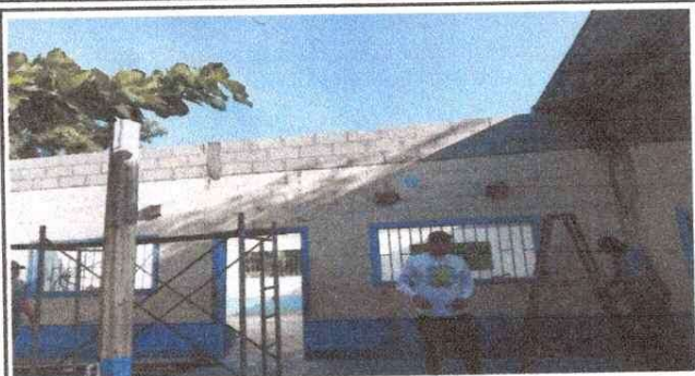
Foto 1: MEJORAMIENTO DE ESTRUCTURA, TECHO PAREDES
