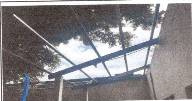
Foto 3: MEJORAMIENTO DE ESTRUCTURA METALICA DEL TECHO
