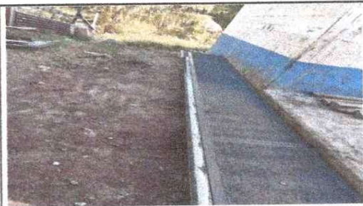
Foto 4: MEJORAMIENTO DE BANQUETA
