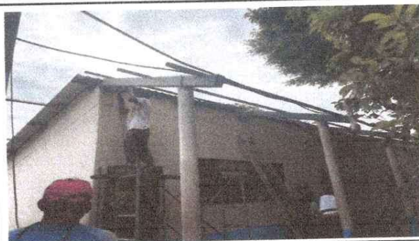
Foto 4: MEJORAMIENTO DE ESTRUCTURA METALICA DEL TECHO
