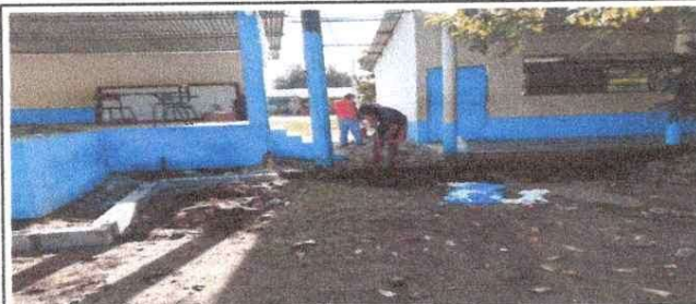
Foto 5: MEJORAMIENTO DE BANQUETA
