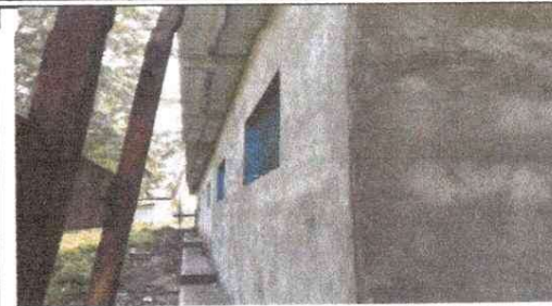
Foto 2: MEJORAMIENTO DE PAREDES DE AULA
