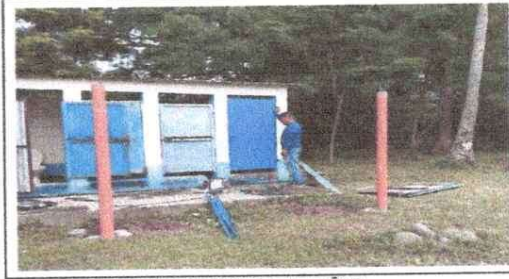
Foto 6: MEJORAMIENTO DE PUERTAS DE BAÑOS
