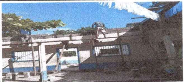
Foto 3: MEJORAMIENTO DE PAREDES DE AULA
