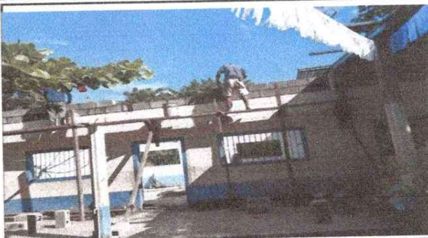
Foto 2: MEJORAMIENTO DE ESTRUCTURA, TECHO Y PAREDES
