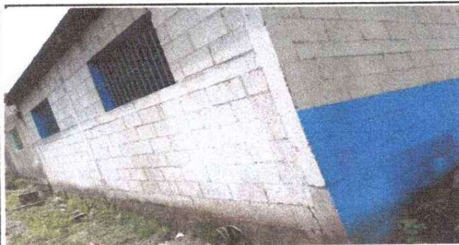
Foto 5: MEJORAMIENTO DE PAREDES
