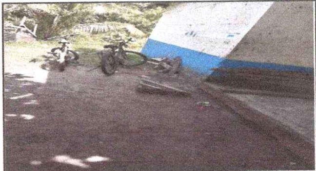
Foto 4: MEJORAMIENTO DE BANQUETA
