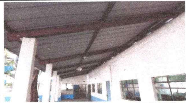
Foto 2: MEJORAMIENTO DE ESTRUCTURA METALICA DEL TECHO
