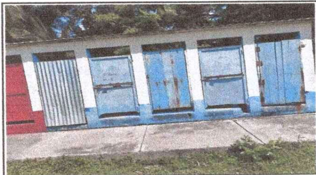
Foto 3: MEJORAMIENTO DE PUERTAS DE BAÑOS
