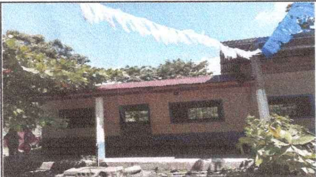
Foto1: MEJORAMIENTO DE TECHO Y PAREDES
