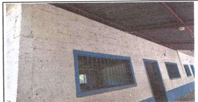
Foto 6: REPELLO DE 3 AULAS Y COCINA
