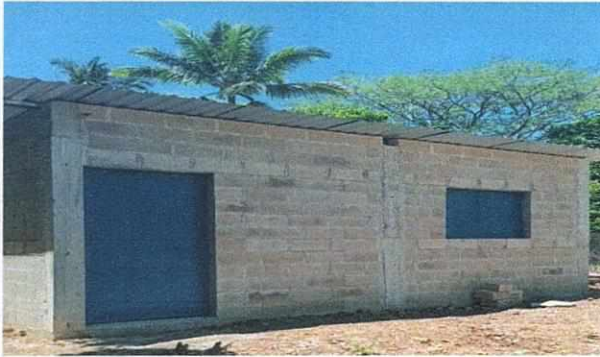
Foto 1: Trabajos de mejoramiento de paredes de cocina finalizados.
