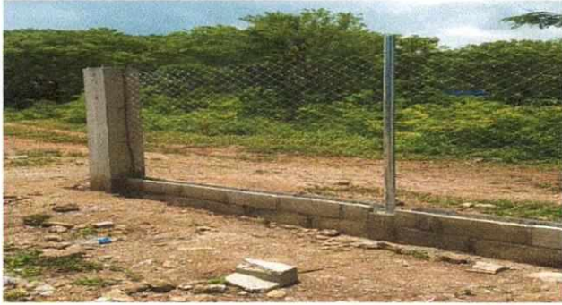
Foto 1: Muro perimetral Finalizado.
