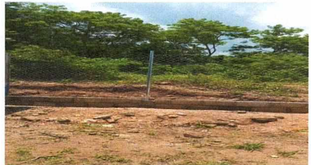
Foto 6: Muro perimetral finalizado..
