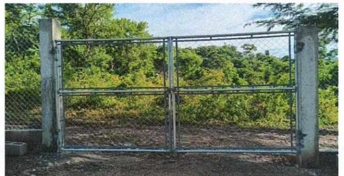
Foto 4: Mejoramiento de portón de malla metálica acceso principal terminado.
