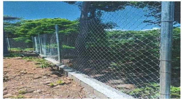
Foto 4: Muro perimetral finalizado.
