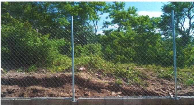
Foto 3: Muro perimetral finalizado.
