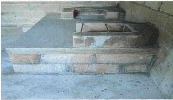
Foto 5: Trabajos finalizados de mejoramiento de polletón.
