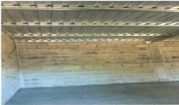
Foto 3: Lámina y estructura metálica galvanizada sustituida en cocina. Torta de cemento mejorada. (Trabajos completados)
