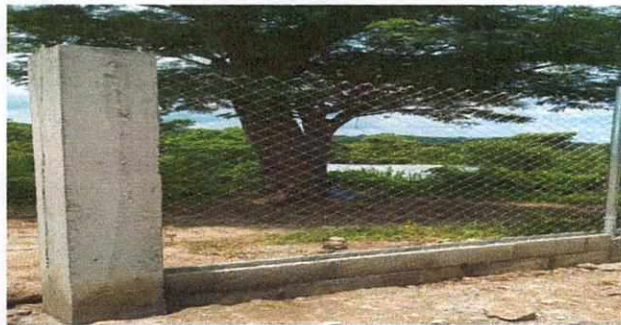
Foto 5: Reforzamiento con pilar de concreto para soporte de portón finalizado.
