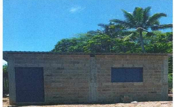
Foto 2: Sustitución de lámina dañada por lámina troquelada calibre 26 de cocina terminada.
