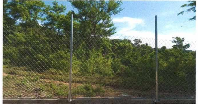
Foto 2: Muro perimetral finalizado.
