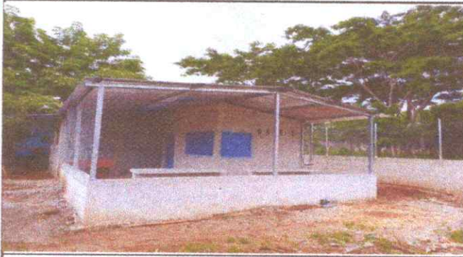
Foto 1: MEJORAMIENTO DE MURO COCINA CON BLOCK, TUBO Y MALLA GALVANIZADA.
