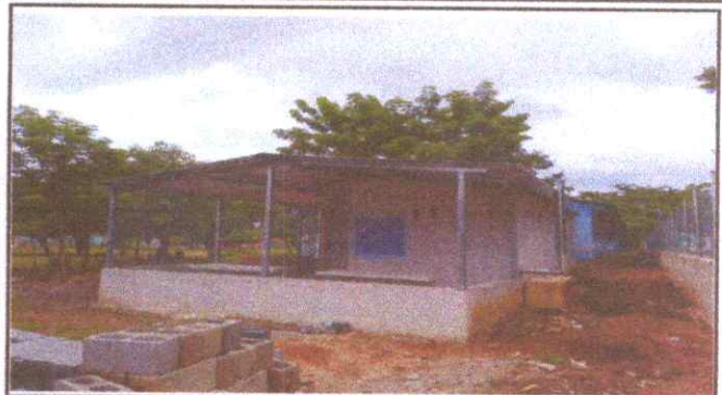
Foto 2: MEJORAMIENTO DE MURO COCINA CON BLOCK, TUBO Y MALLA GALVANIZADA.
