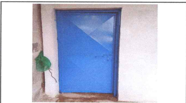
Foto 3: INSTALACIÓN DE PUERTA
