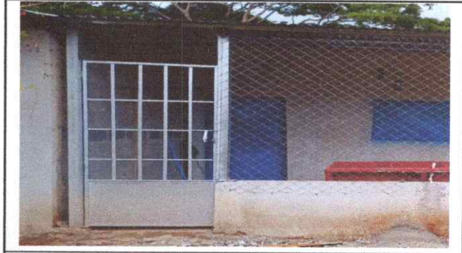
Foto 2: INSTALACIÓN DE BALCON
