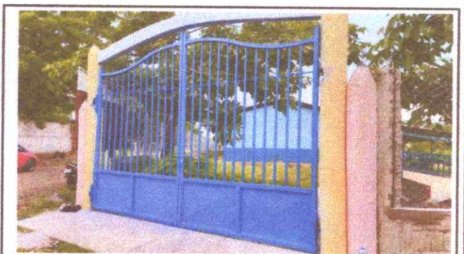
Foto 4: MEJORAMIENTO E INTALACIÓN DE PORTON DE ENTRADA PRINCIPAL
