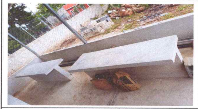
Foto 1: MEJORAMIENTO DE MUEBLE DE COCINA Y PISO DE CONCRETO
