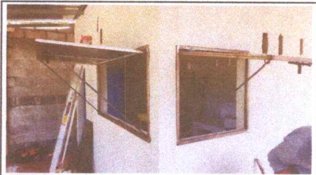
Foto 2: Instalación de ventanas
