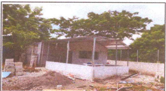
Foto 4: Levantamiento y circulación de cocina con muro de tres hiladas de block, tubo y malla.
