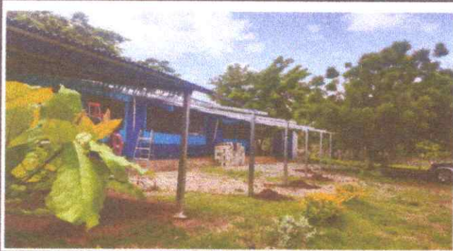
Foto1: Estructura y lamina de techo de galera
