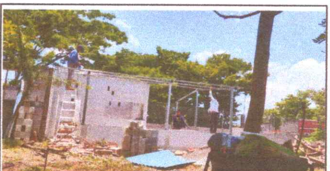
Foto 6: Trabajos en techo de cocina
