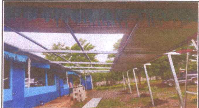
Foto 2: Estructura y lamina de techo de galera
