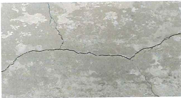
Foto 5: Piso de torta de cemento en cocina dañado a mejorar,
