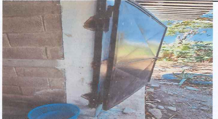
REPARACION DE PUERTAS Y CHAPAS
