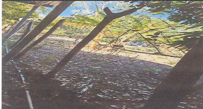
MEJORAMIENTO DE MURO PERIMETRAL EXISTENTE POR MURO DE BLOCK MAS MALLA METALICA.
