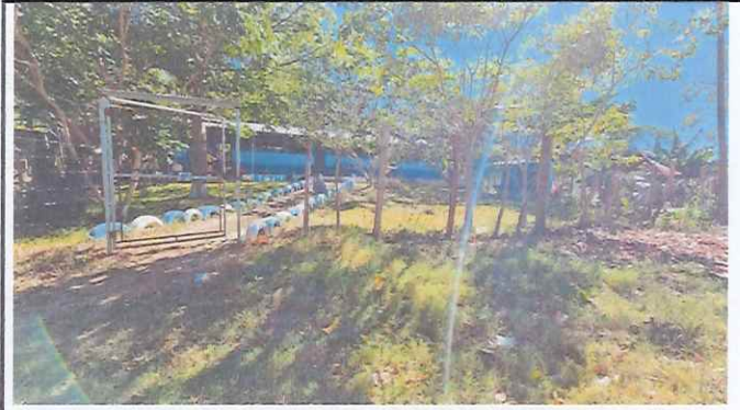
MEJORAMIENTO DE MURO PERIMETRAL EXISTENTE POR MURO DE BLOCK MAS MALLA METALICA.
