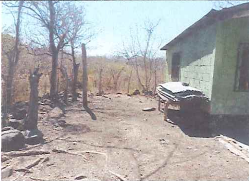
Sustitucion de polleton de barro, por polleton de Block con plancha
