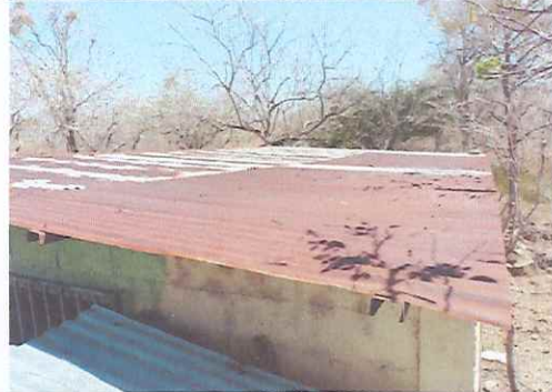
Se necesita mantenimiento de lámina para mas durabilidad
