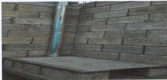
Foto 5: INSTALACION DE PLANCHA
