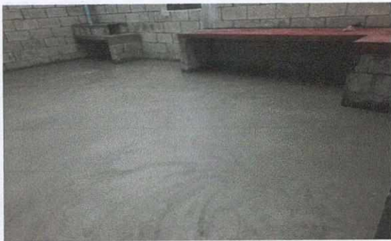
Foto 3: MESA DE CONCRETO
