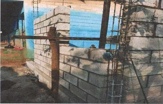
Foto 1: LEVANTAMIENTO DE PAREDES
