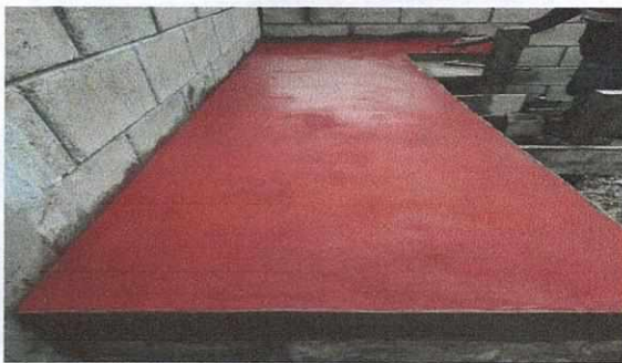
Foto 3: MESA DE CONCRETO
