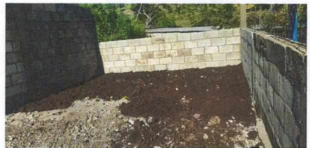
Foto 6: CONSTRUCCION DE PAREDES
