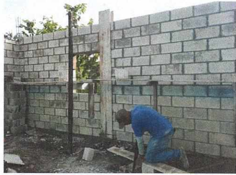
Foto 2: LECANTAMIENTO DE PAREDES DE LA COCINA
