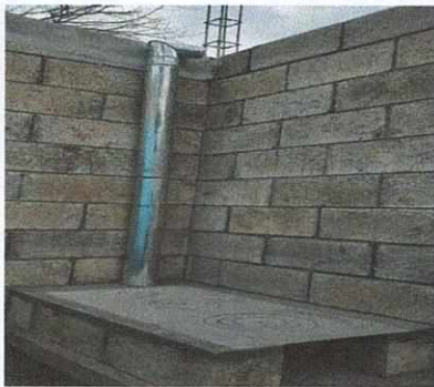
Foto 5: INSTALACION DE PLANCHA
